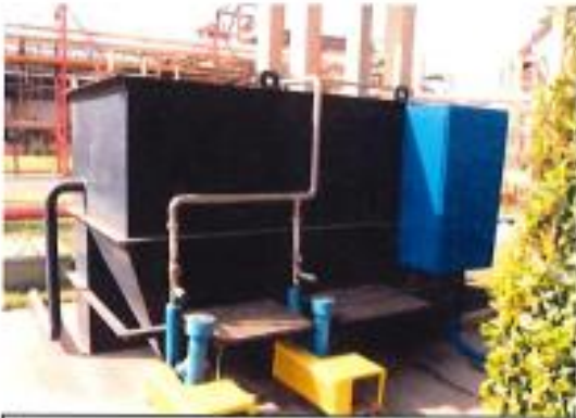
Planta de Tratamiento Compacta
