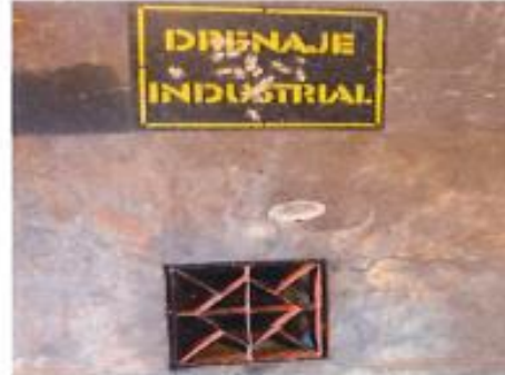
Rejilla de Drenaje de Industriales
